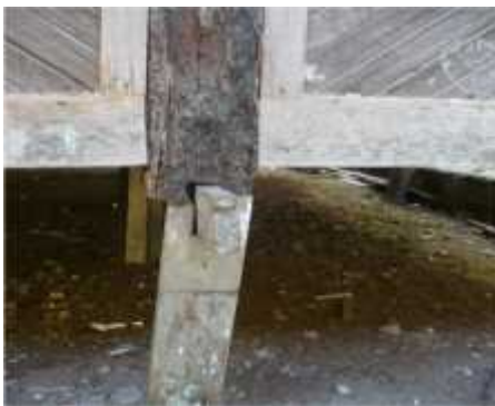
Figure 10.0 Sistem konstruksi pasak
